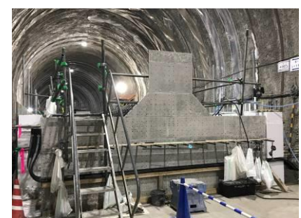
写真-3 設置完了状況
