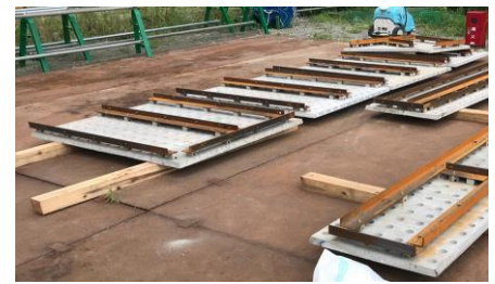
写真-1 地組状況
