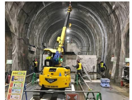
写真-2 現地での設置状況
