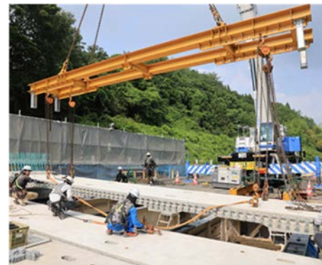
写真-1 道路橋床版の取替工事の状況
