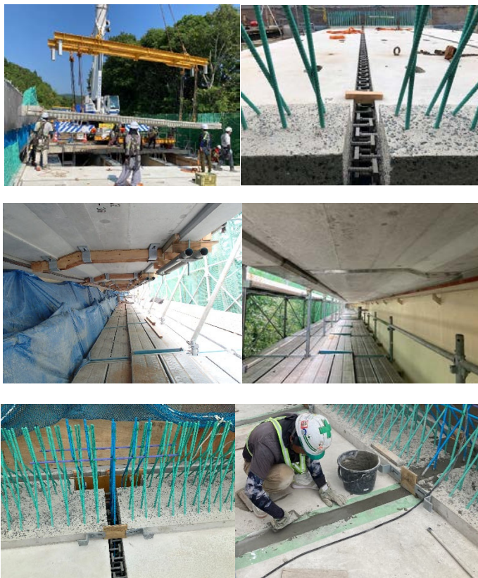
写真-2 床版架設工，型枠工，間詰工の状況
