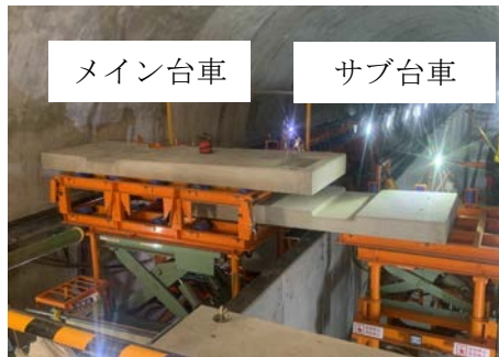
写真-4 中床版設置状況
