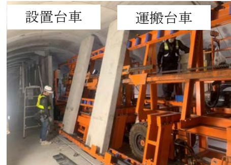
写真-5 上部中壁設置状況
