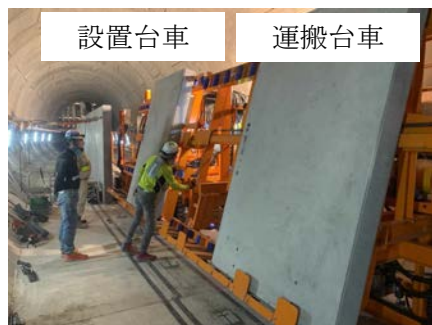
写真-3 下部中壁設置状況
