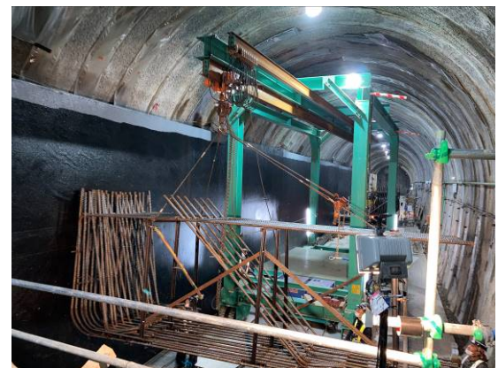
写真-2 プレファブ鉄筋の設置状況
