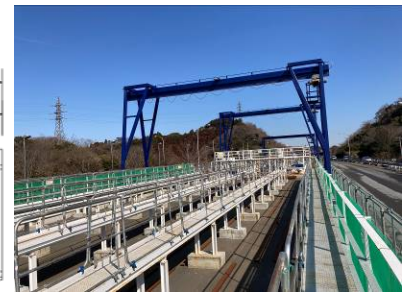
写真-1 鉄筋ヤードの全景
