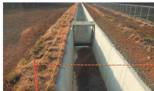
写真-1 集水樹完成写真
