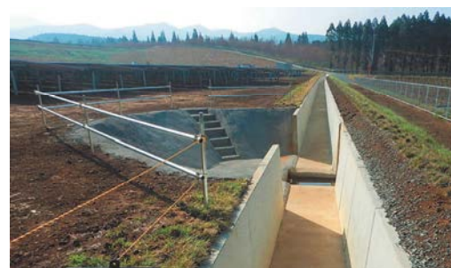
写真-2 集水桝改善策完成
