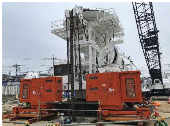
写真-2 水平多軸型掘削機 (BMX) と絶対位置計測装置 (APS)
