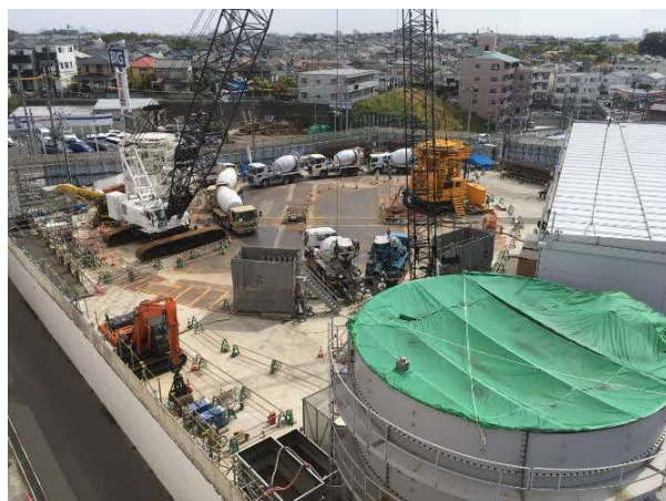
写真-3 施工ヤード全景
