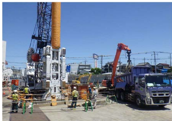
写真-1 MHL 掘削機
