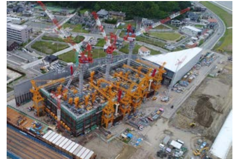
写真-1 現場全体写真
