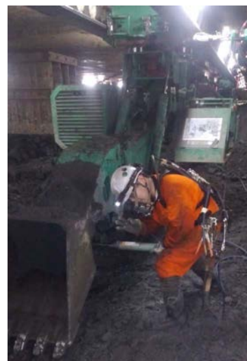
写真-3 ヘリウム混合ガス作業
