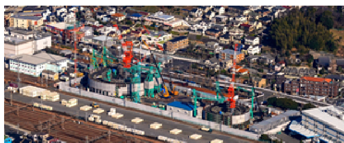
写真-1 非常口（左）と資材搬入口（右）
