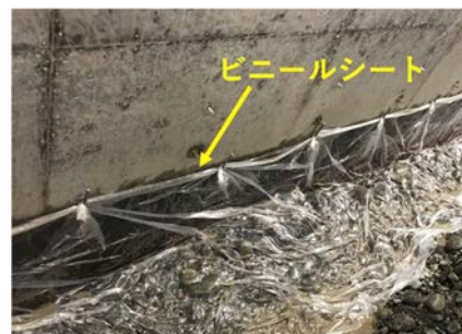
写真 2 ビニールシート施工状況
