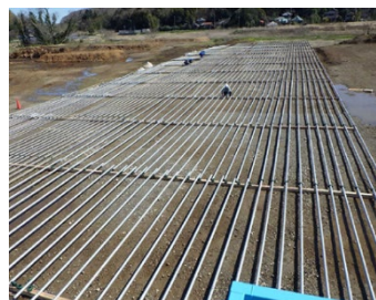
写真-1 配管全景
