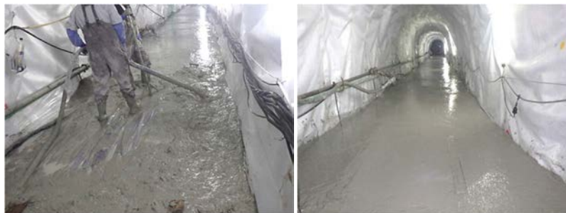
写真 1 基礎コンクリート(高強度高流動モルタル代替)施工状況
