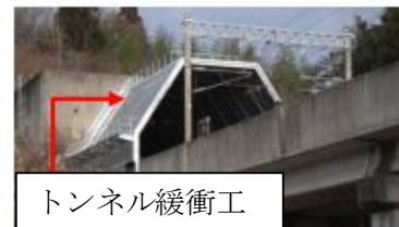
図-1 トンネル緩衝工 1)
