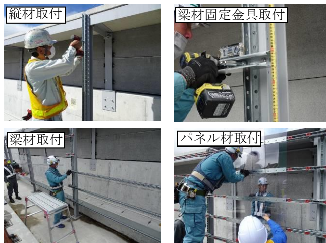
図7 逆L型線防柵施工状況
