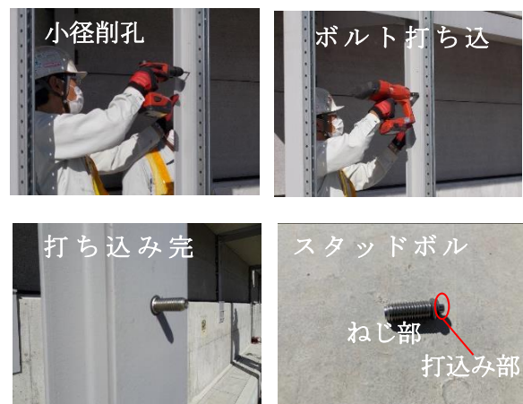
図 4 スタッドボルト打ち込み手順
