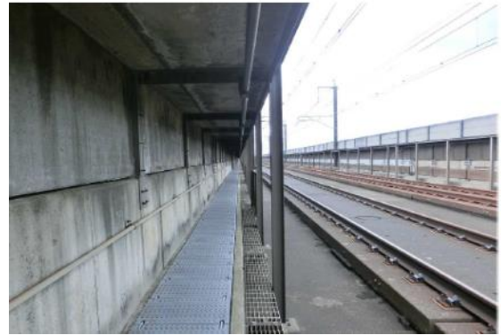
図 1 逆 L 型防音壁設置区間
