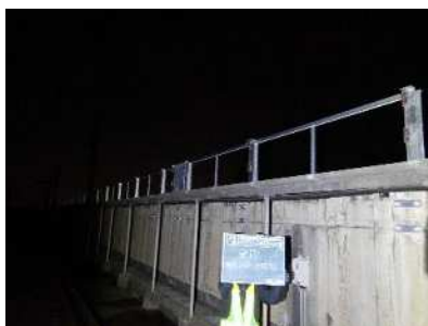
写真-2 防音壁かさ上げ 構造
