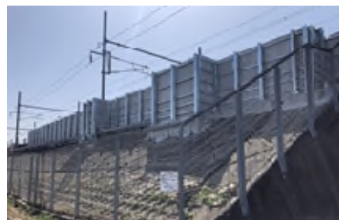
写真-1 新盛土防音壁
