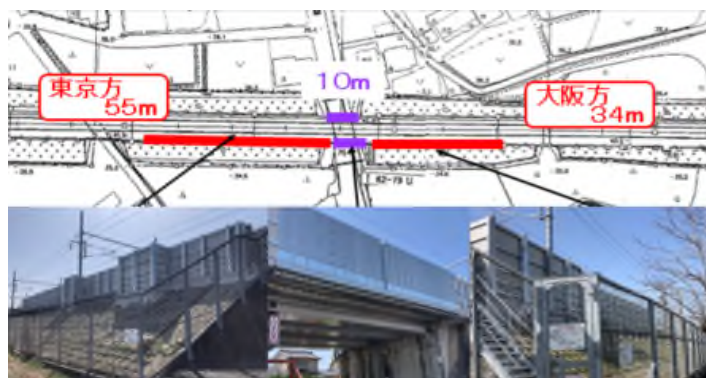
写真-2 工事概要
