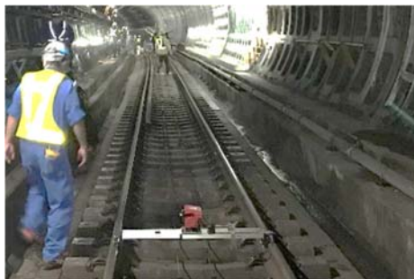
写真-1 建築限界余裕量 測定状況
