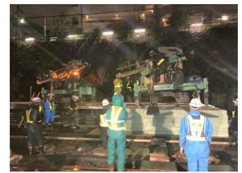
写真-3 削孔機構台積載状況
