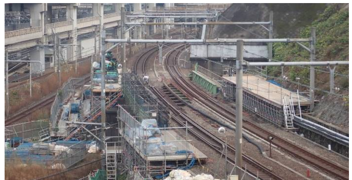
写真-1 作業構台全景
