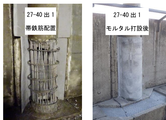
図-6 電化柱基礎部復旧状況
