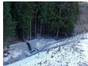
図-9 復旧完了（盛土上より）
