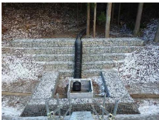
図-8 復旧工事完了
