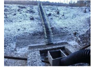
図-10 コンクリート製キャンパス設置
