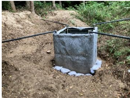
図-5 ためます嵩上げ状況
