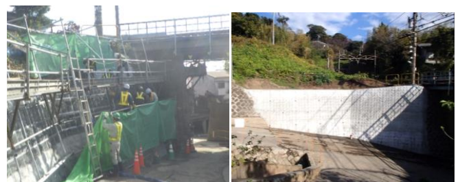
図-5 仮設足場状況
