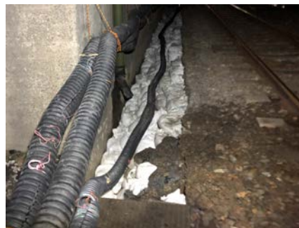
写真-4 ジオテキ置換・土嚢埋め戻し
