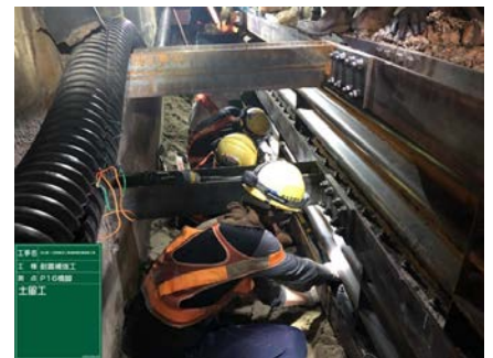
写真-5 ライナープレート設置状況
