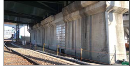
写真-2 橋脚 B
