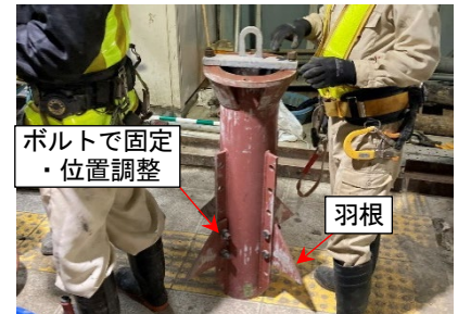
写真-3 羽根付きトレミー管 (改良後)
