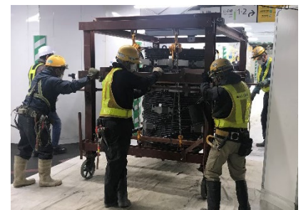
写真-4 かごの場内運搬用フレーム
