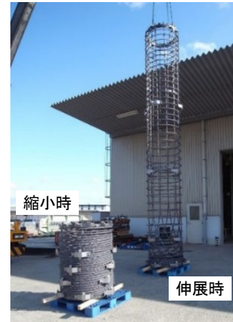
写真-1 伸縮式鉄筋かご
