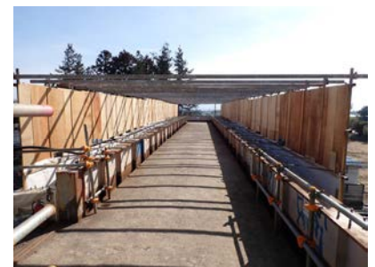
写真-6 足場組立て状況
