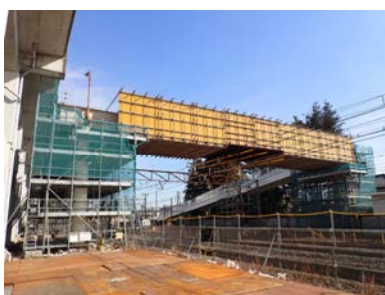
写真-2 吊り足場設置完了
