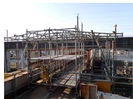
写真-4 移動用構台
