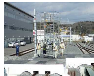
写真-2 EPS ブロック試験施工（ローリングタワー使用）
