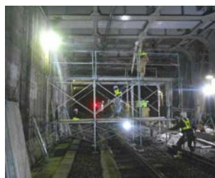
写真-1 掛け払い足場の例
