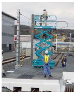
写真-3 EPS ブロック試験施工 (小型高所作業車使用)
