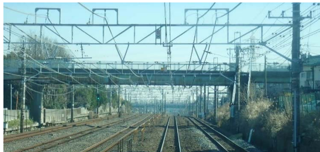
写真-1 跨線橋 全景
