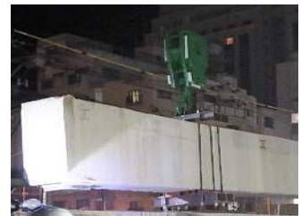
写真-2 撤去状況
