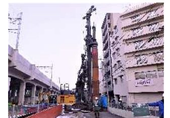
写真-4 施工状況
