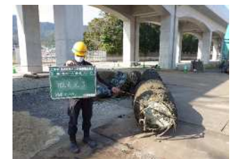
写真-3 撤去後確認
