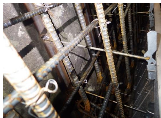
写真 4-2 セパレーター組立状況
