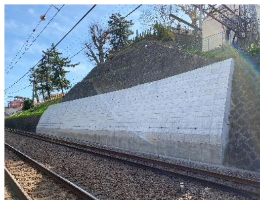
写真 4-3 残存型枠全景
