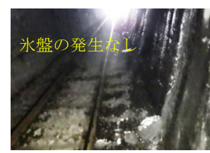
図-7 目地充填実施後 結氷・氷盤発生状況（2022年）
