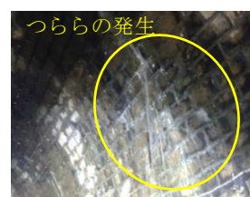
図-7 目地充填実施後 結氷・氷盤発生状況（2022年）
