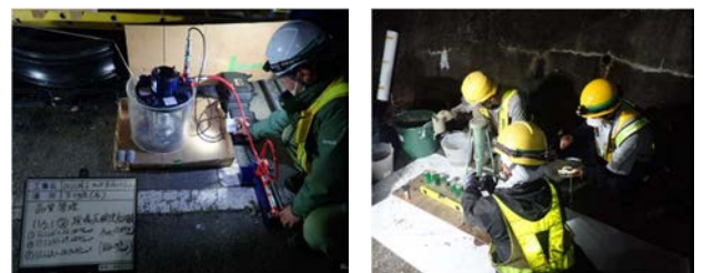
写真-4 現場圧縮強度・フロー試験状況
