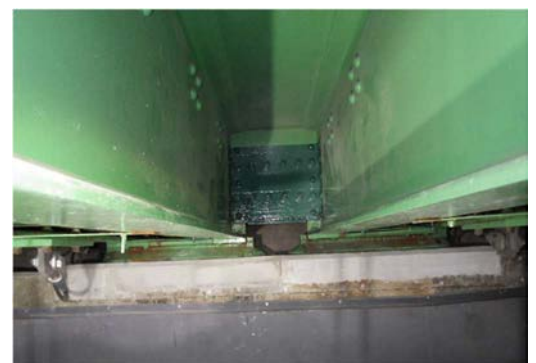
写真-5 沓座コンクリート打替え後
