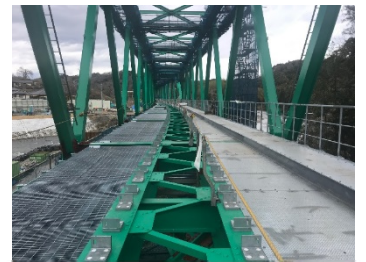
写真-3 枕木受けを含む縦桁
