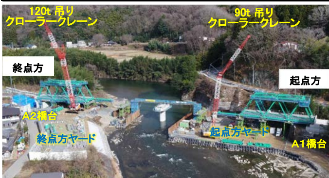
写真-4 クローラークレーンを用いた桁架設状況
