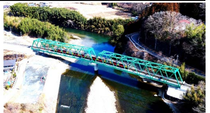
写真-5 運転再開した第6久慈川橋りょう
