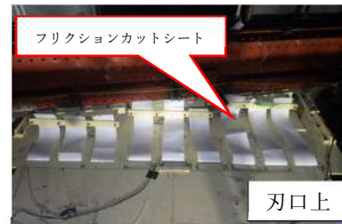
写真-1 フリクションカットシート設置状況
