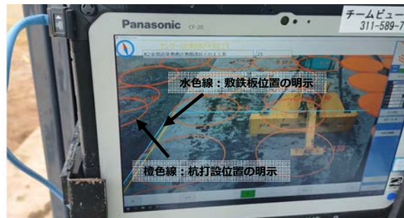
写真-3 AR活用による敷鉄板の敷設
