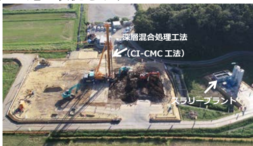
写真-1 施工状況
