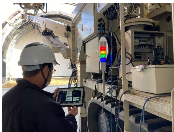
写真-2 タブレットによる自動建込み確認状況
