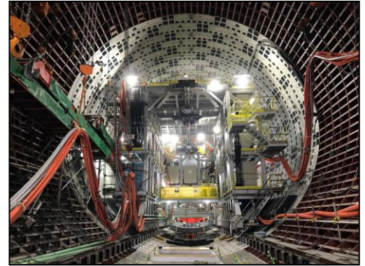
写真-1 セグメント組立完了状況
