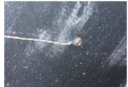
写真-3 管路への圧力計設置状況
