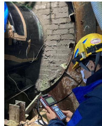
写真-5 充填圧計測状況
