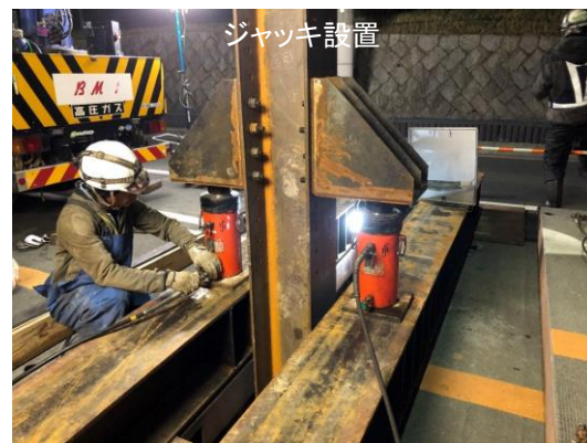
写真-2 杭ジャッキアップ状況
