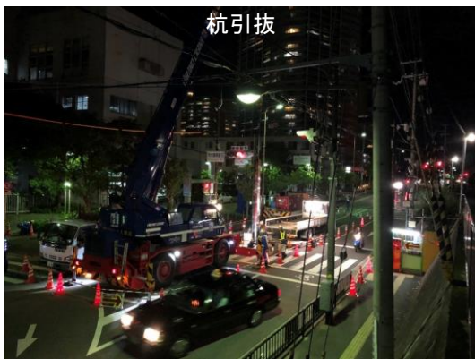
写真-1 杭引抜撤去状況
