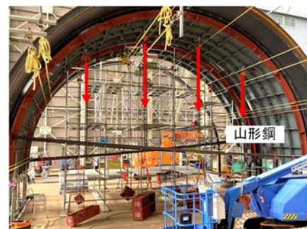
写真 3 載荷試験状況
