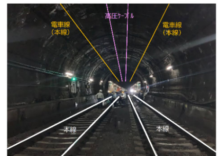
図4 一般部セグメント設置計画
