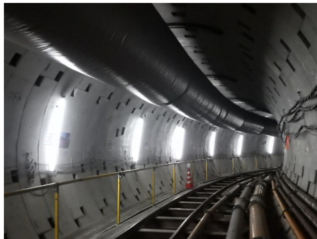
写真. 7-2 トンネル坑内(急曲線部 R=50m)
