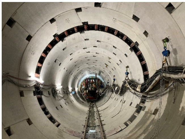
写真. 7-1 トンネル坑内(直線部)
