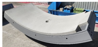
写真.4-1 本工事のICセグメント
