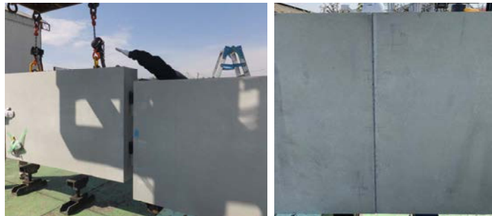
写真-4 組立試験状況
