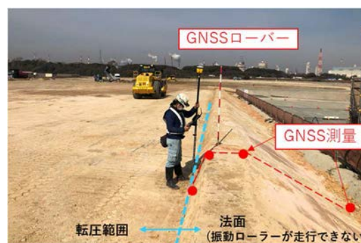
図-5 GNSS ローターによる法面計測
