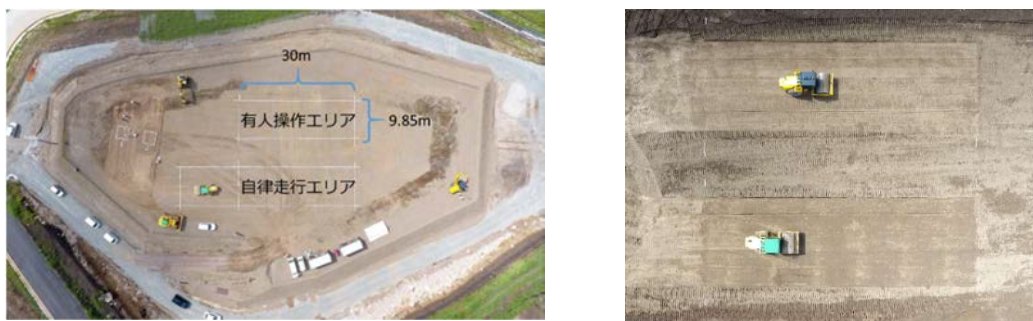
写真-1 実証実験の様子
