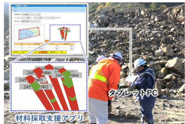
写真-1 立会時の品質確認
