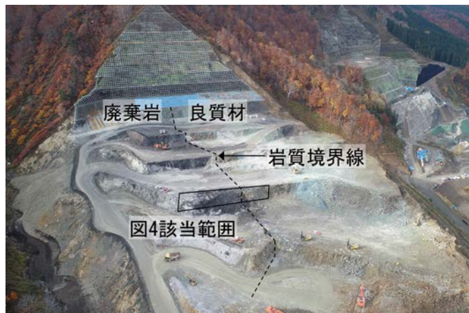
図-2 原石山の掘削状況（2020年11月時点）
