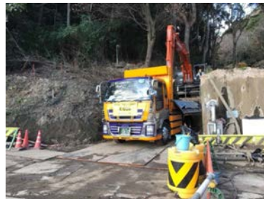
写真-1 現場仮置き場の全景
