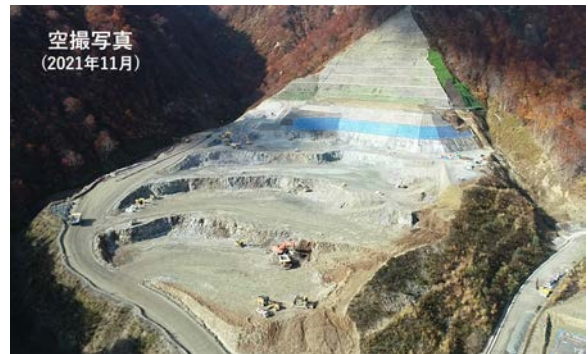
写真-1 赤滝原石山全景（空撮写真）
