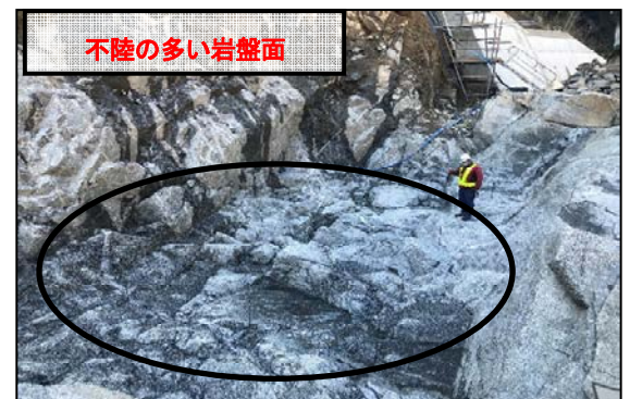
図-2 掘削面状況
