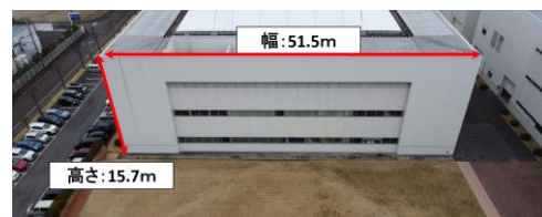
図-3 対象となる実験棟壁面 (航空写真)
