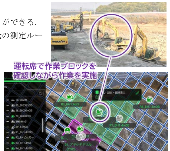
図-4 重機オペレータ活用事例
