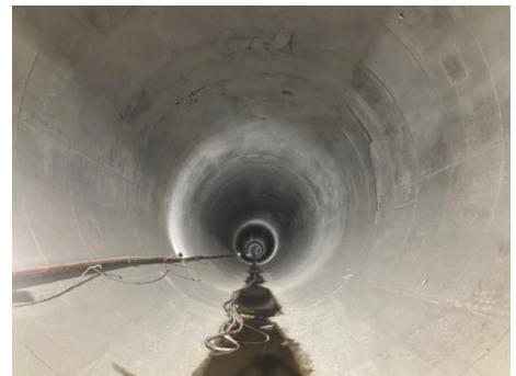
写真-2 導水トンネル覆工仕上がり
